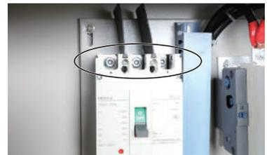
**5** 配線ボックス内のブレーカーに電源コードを接続し、六角ボルトを締めます。白線を中性線とし、左側から、赤、白、黒色を接続します。緑色の線は、アース線なのでそのままにします。
