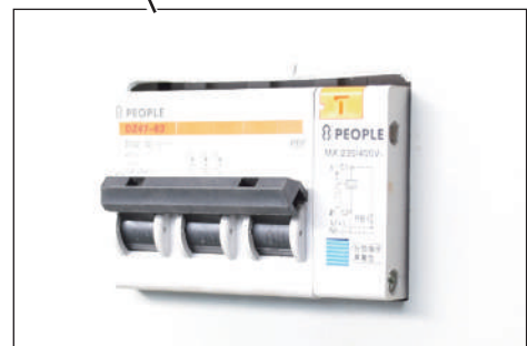
背面にブレーカー（遮断器）
