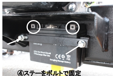
④ステーをボルトで固定
